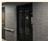
エレベーター
